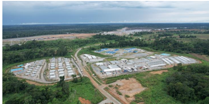
Vue aérienne de l'aire des entreprises de Nachtigal
