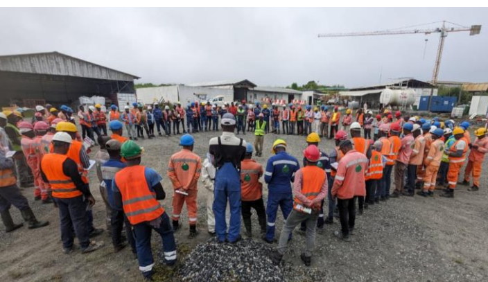
Déroulement de la journée sur le chantier
