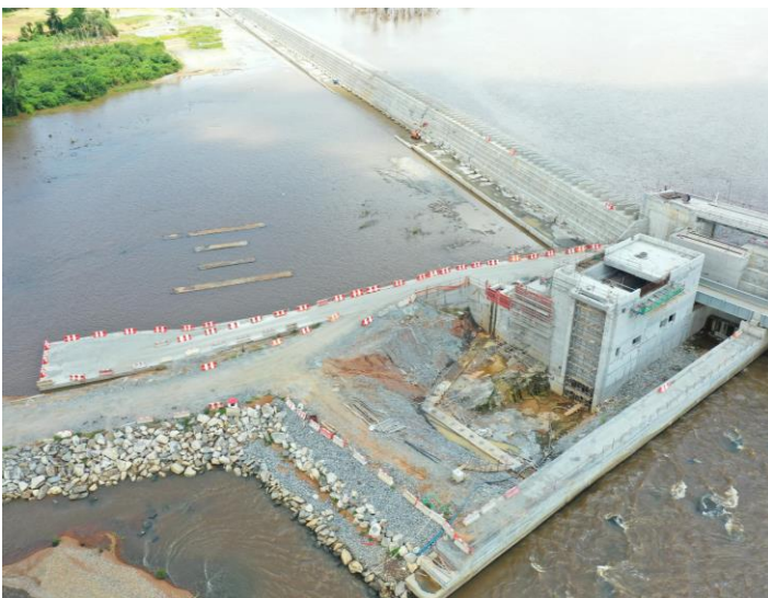
Vue aérienne de l'usine de débit réservé
