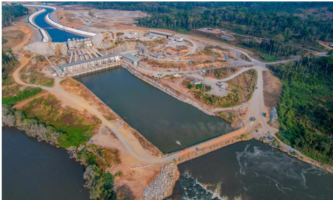
Vue aérienne du canal de fuite de Nachtigal
