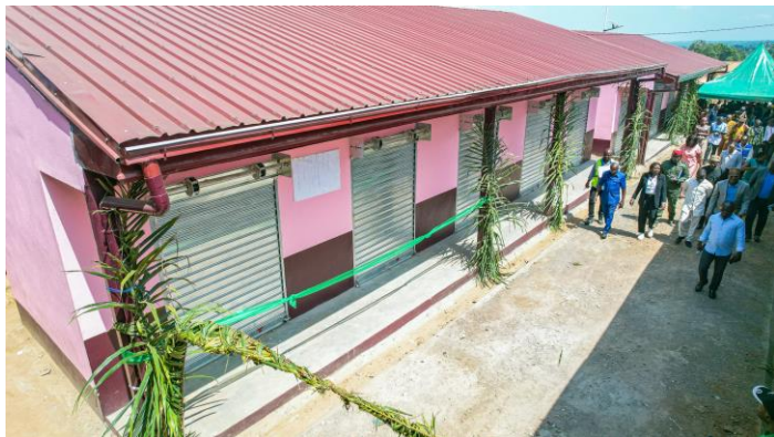
Photo des boutiques construites
