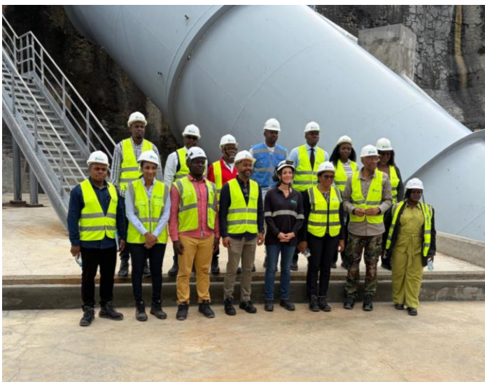
Photo de groupe devant les conduites forcées de l'aménagement
